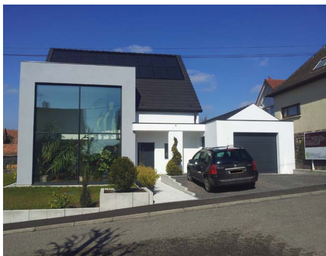
Maison passive construite dans le Bas-Rhin par l'entreprise Kintzelmann construction
